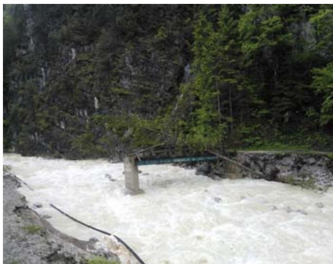
*Weggerissen wurde die Radwegbrücke in St. Adolari. Auf einen Wiederaufbau wird verzichtet. Abgerissen wurde in diesem Bereich auch der Hauptkanal und die Wasserleitung.*
