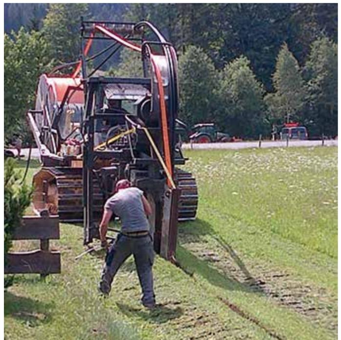
**Modernste Technik auch bei der Verlegung des Glasfasernetzes. Einsatz des Kabelpfluges.** Foto: ersiBILD
