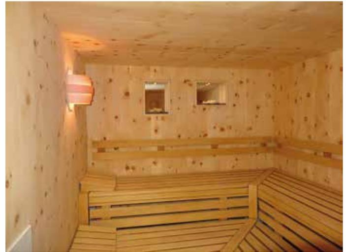
Nach kurzer Rücksprache mit der Gemeindeführung, haben wir uns entschlossen, diese Sauna nicht nur zu sanieren, sondern komplett zu erneuern. Die Isolierung wurde großteils erneuert und die Dichtfolie hergerichtet. Die Wände und die Decke wurden mit Zirbenplatten ausgekleidet, alle Bänke geschliffen und neue Lichter und Kristallkästchen eingebaut.
