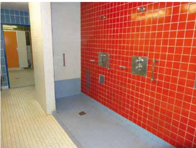
Die Dusch- und WC-Anlagen waren in katastrophalem Zustand. Einige der Duschen und WCs haben nicht mehr funktioniert und waren auch nicht mehr zu reparieren. Neben dem optischen Problem, waren mittlerweile auch die hygienischen Grundvoraussetzungen fast nicht mehr zu gewährleisten! Ohne die Sanierung konnten die sanitären Einrichtungen des Bades einfach nicht mehr genutzt werden.
